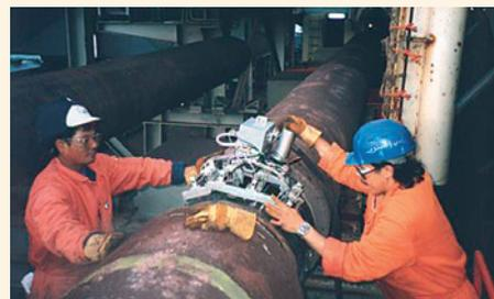
Рис.1. Установка моторизованного сканера на стыковой сварной шов в условиях трубоукладочной баржи
